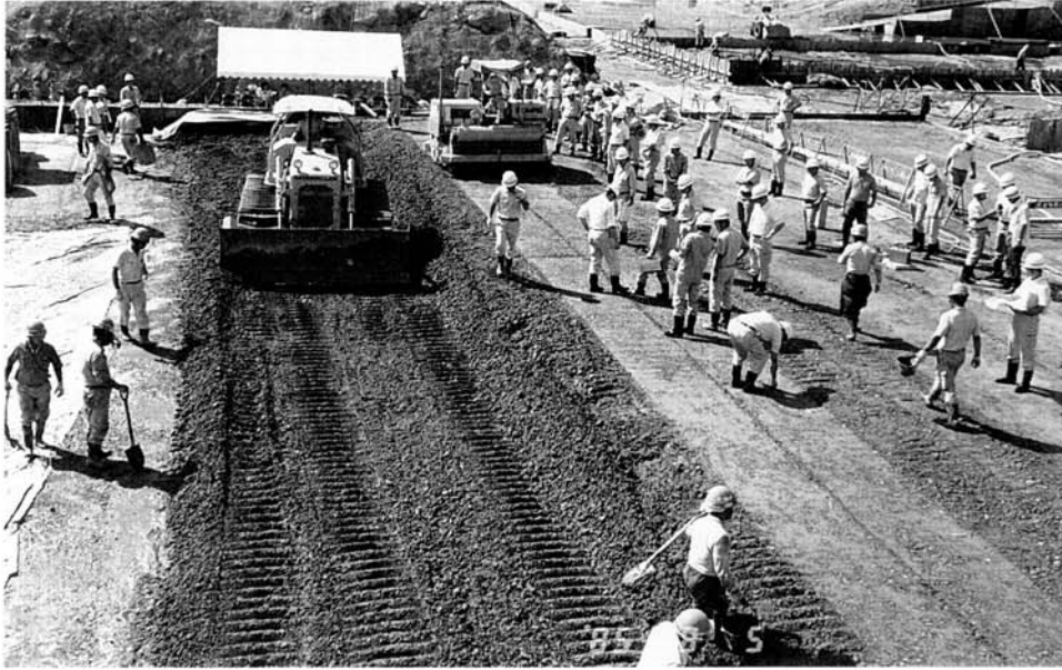
Photo 13 Test fill. Planche d'essai.
