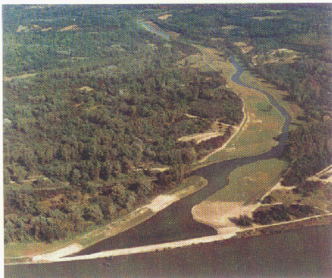
Photo B - Le canal de Giessgang près de Greifenstein, section déversante. Giessgang near Greifenstein, overflow section.
