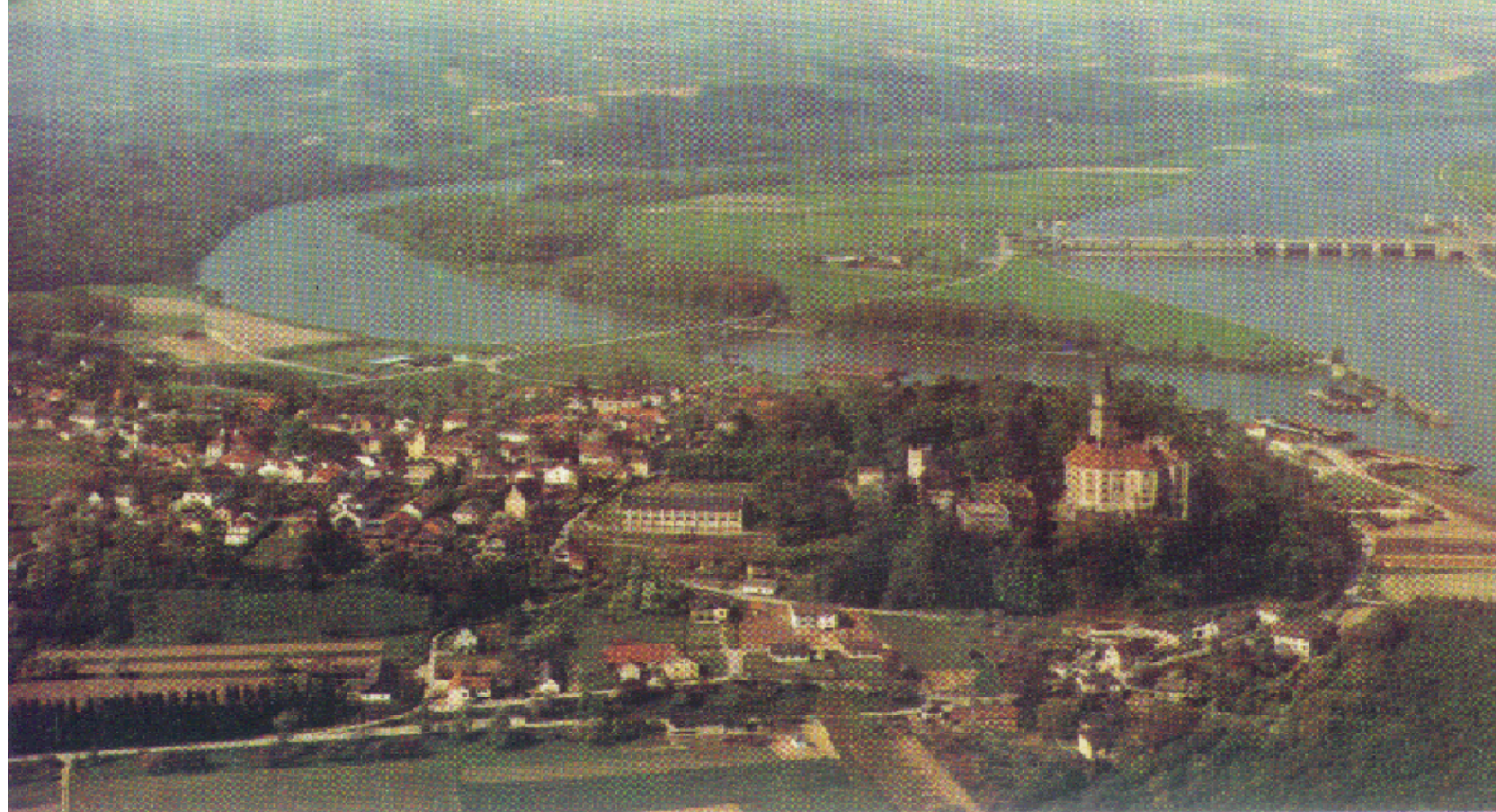
Photo A - Aménagement de Wallsee-Mitterkirchen sur le Danube. Usine - évacuateur de crue - écluse à double sas. Sur la gauche, bras mort préexistant. Wallsee-Mitterkirchen power scheme on the Danube. Powerhouse - spillway - twin locks. Pre-existing dead branch to the left. The power scheme was constructed in a dry construction pit.
