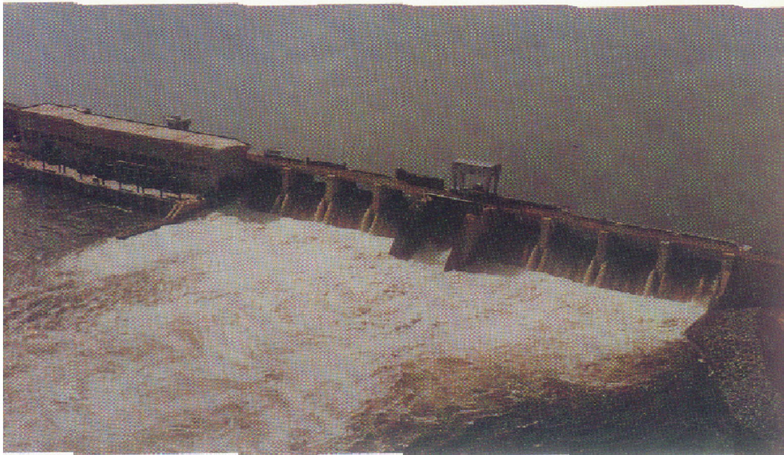
Photo H - Selingué Dam (Mali). Évacuateur de crue - Spillway.
