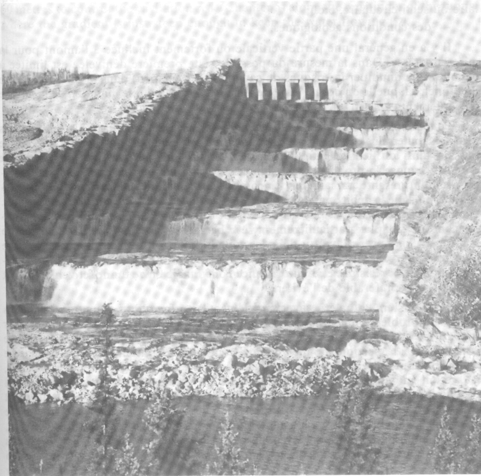
Barrage de La Grande 2 (Canada). Évacuateur de crue (16 140 m 3 /s).
