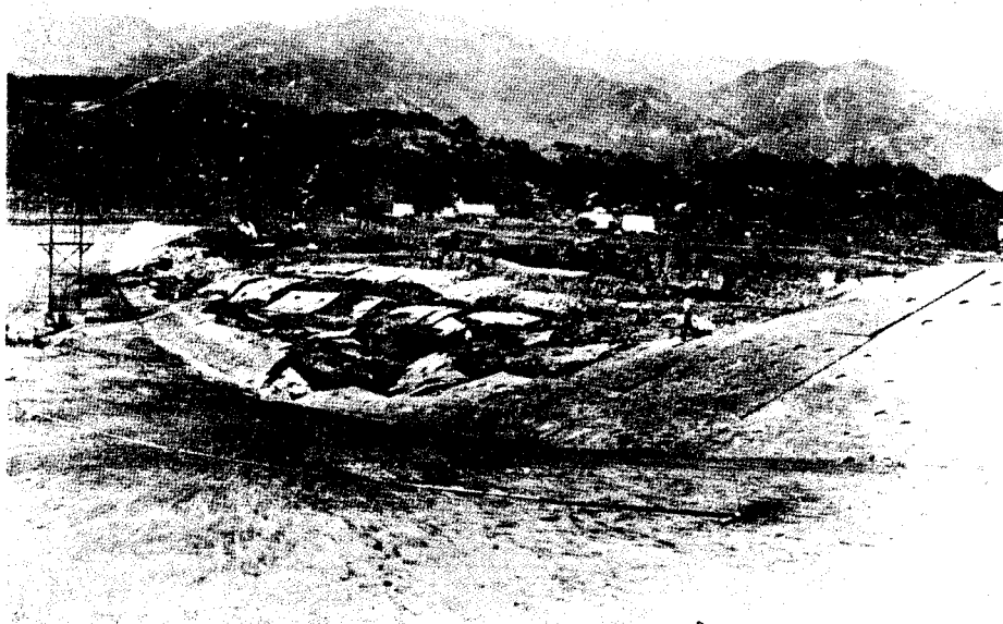
Fig. 12. — Sheffield Dam after failure. Le barrage de Sheffield après rupture.
