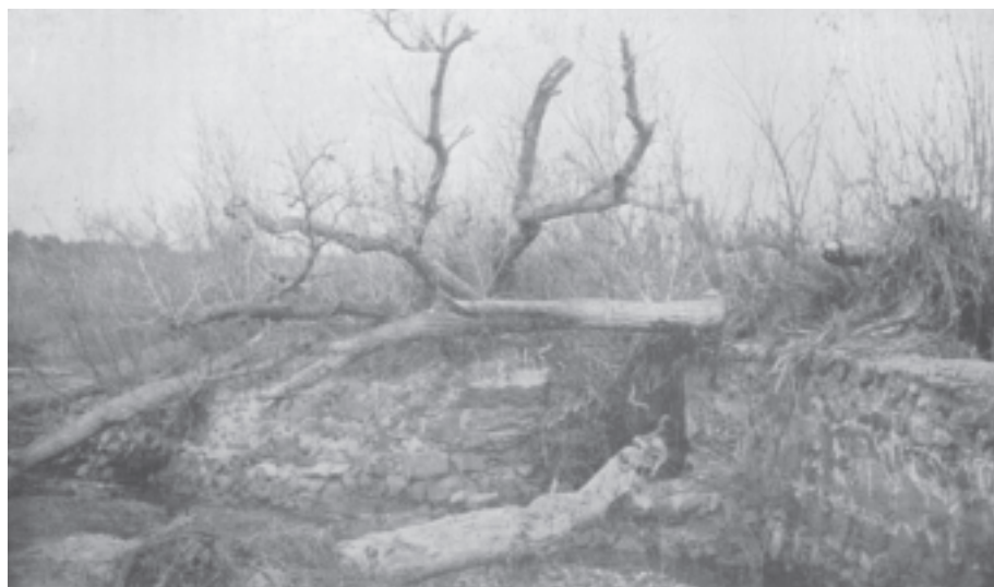
Fig. 82 Barrage d'irrigation d'Old Mission près de San Diego, Californie, USA, en maçonnerie et mortier datant de 1770 dans la mission jésuite de San Diego
