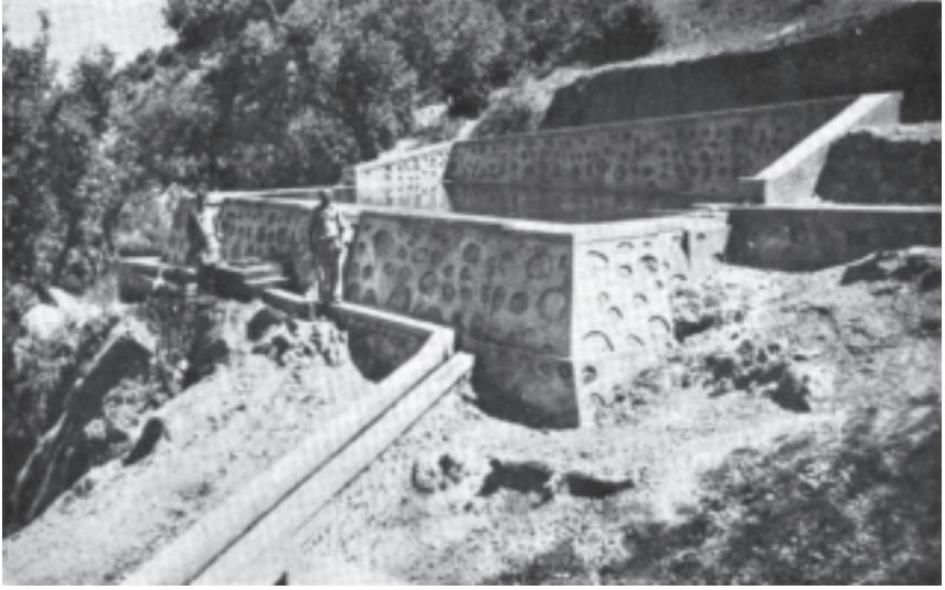
Fig. 15 Réservoir en maçonnerie et canal de prise
