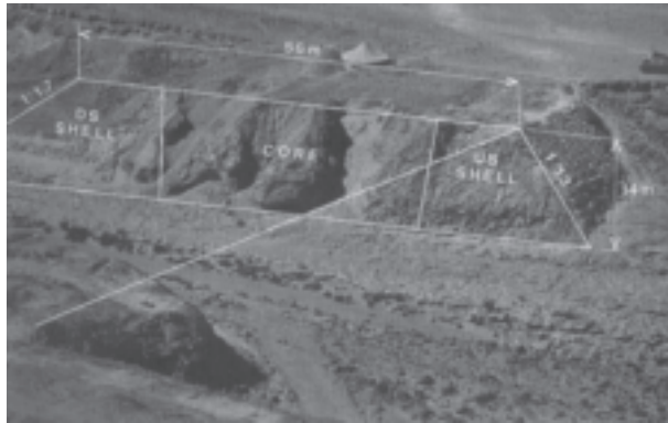
Fig. 1 Vue depuis la rive gauche du site du barrage de Kafara (Schnitter/94)
