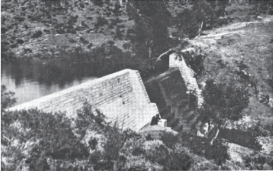
Fig. 14 Le barrage en maçonnerie de Kophinou
