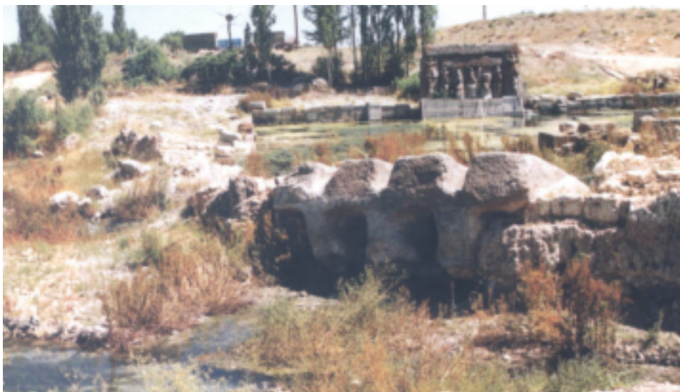
Fig. 72 Évacuateur du barrage d'Eflatunpinar
