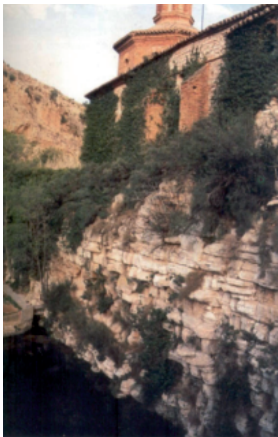
Fig. 60 Le barrage romain de Muel depuis l'aval avec l'hermitage du 18 e siècle construit sur sa crête (Arenillas/2006)
