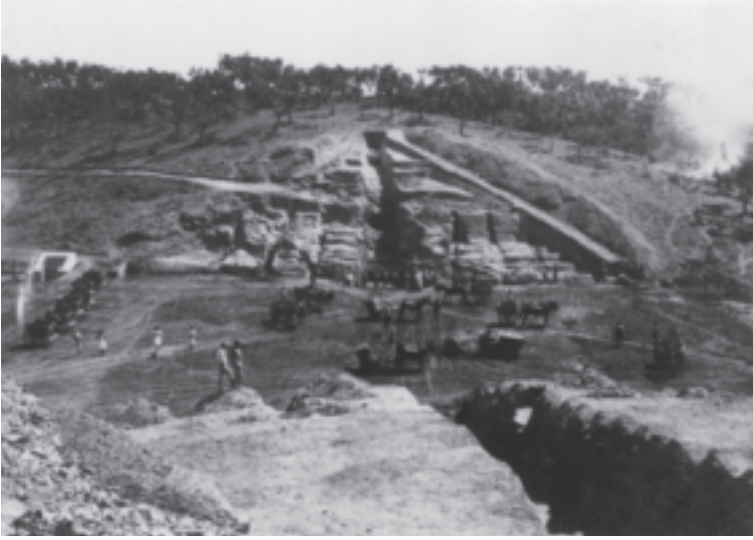
Fig. 52 Excavation des tranchées de drainage et d'étanchéité [1]
