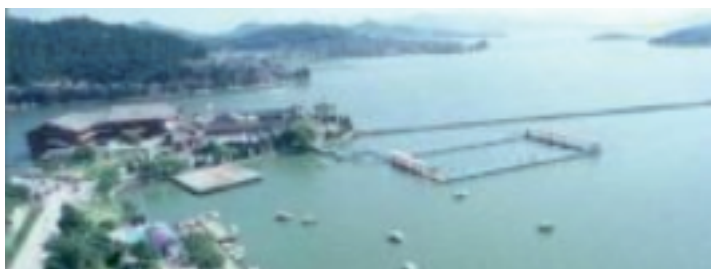
Fig. 10 Remblai du lac Dongqian construit en 744, de 45 km de long
