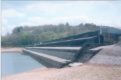
Fig. 23 Torcy-Vieux dam : upstream face
