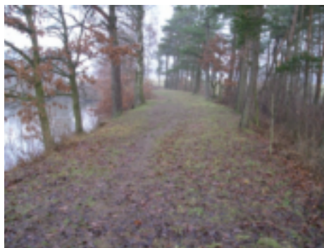
Fig. 19 Barrage de l'étang Regent construit en 1479 - 5,5 m de haut et 340 m de long
