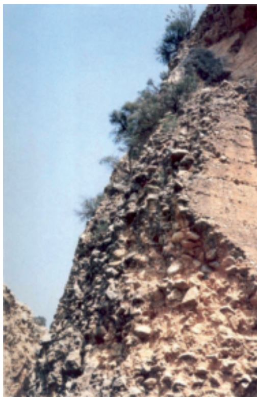
Fig. 66 Ruines de l'appui rive droite du barrage de Malpasillo 14 e siècle (Arenalles/2006).
