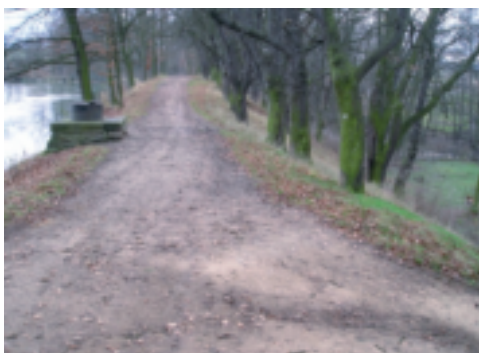
Fig. 20 Barrage Stebensky construit en 1720, 7,6 m de haut et 180 m de long
