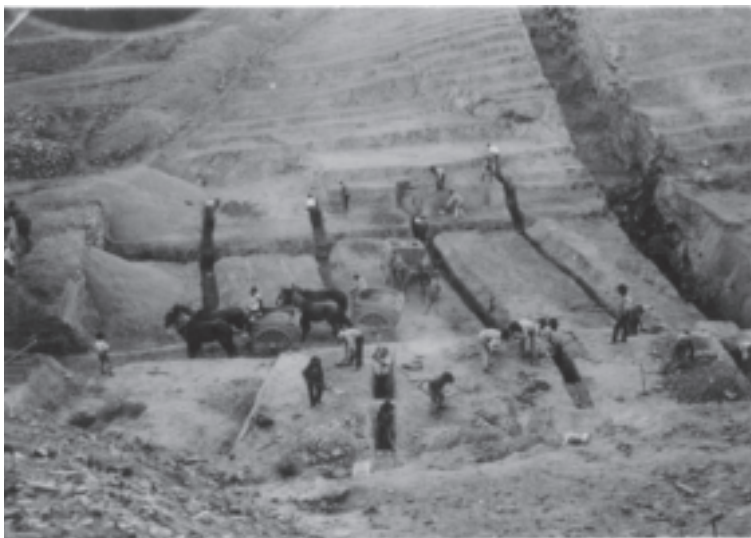
Fig. 50 Vue générale du barrage de Fontes pendant sa construction en 1937 [1]
