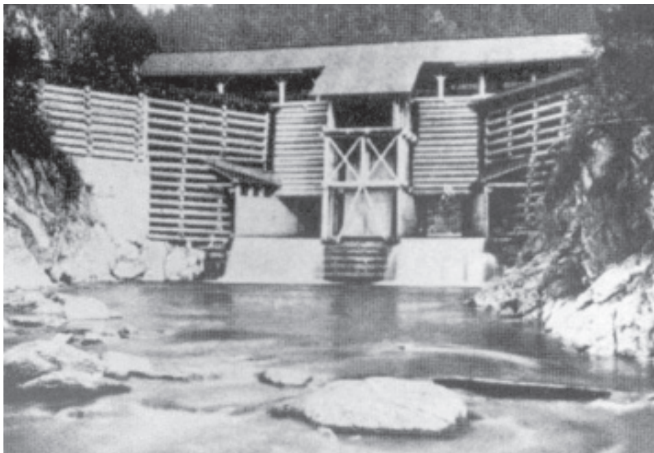
Fig. 6 Barrage en rondins de l'archiduc Jean en Autriche
