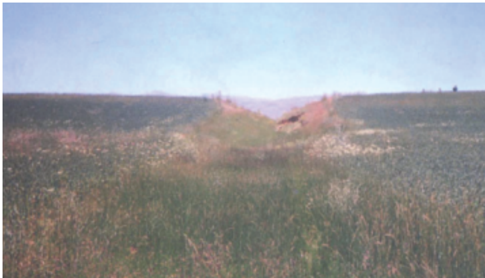
Fig. 70 Vue aval du barrage de Karakuyu
