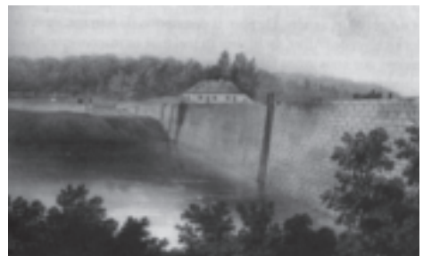
Fig. 26 Barrage de Saloup : parement amont
