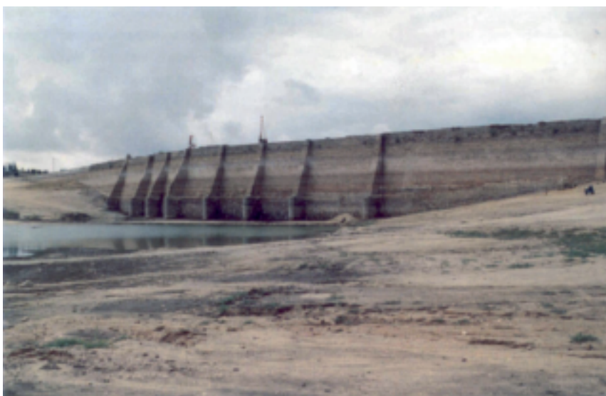
Fig. 61 Le barrage romain de Proserpina depuis l'amont en 1992 (Arenillas/2006)
