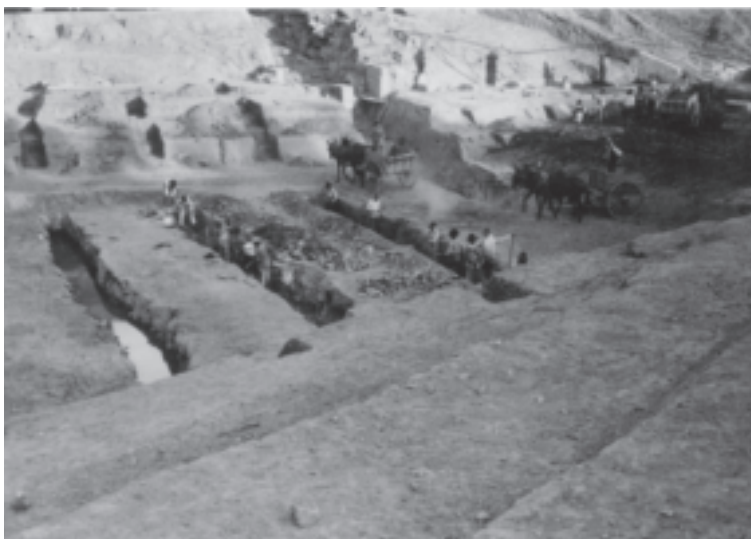
Fig. 51 Première phase de compactage de la terre dans le chenal en rivière [1]
