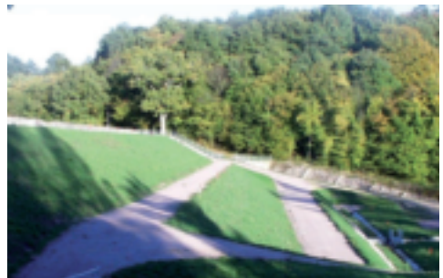
Fig. 24 Torcy-Vieux : parement aval après le renforcement de 2000
