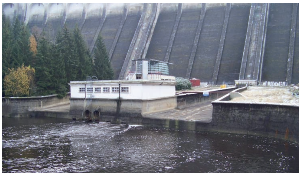
Fig. 9 Vidange de fond, Barrage d'Eupen, Belgique
