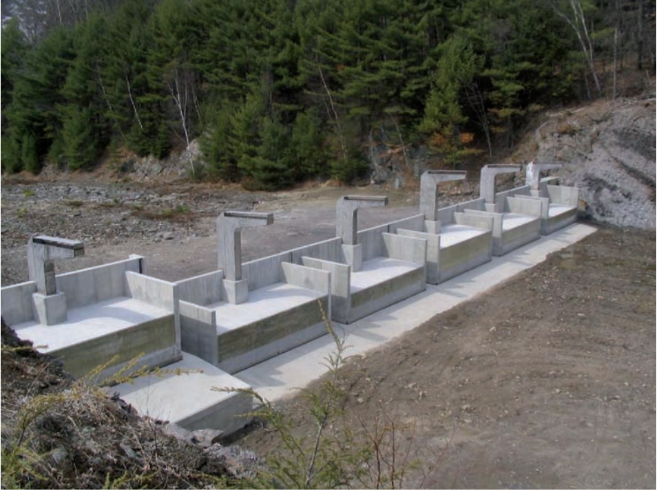
Fig. 8 Plot fusible en béton, Barrage Terminus, Californie, USA
