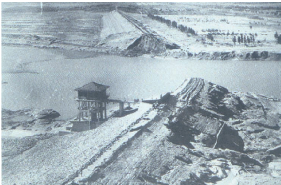
Fig. 16 Barrage Banqiao (Rivière Ruhe, Chine) après la rupture
