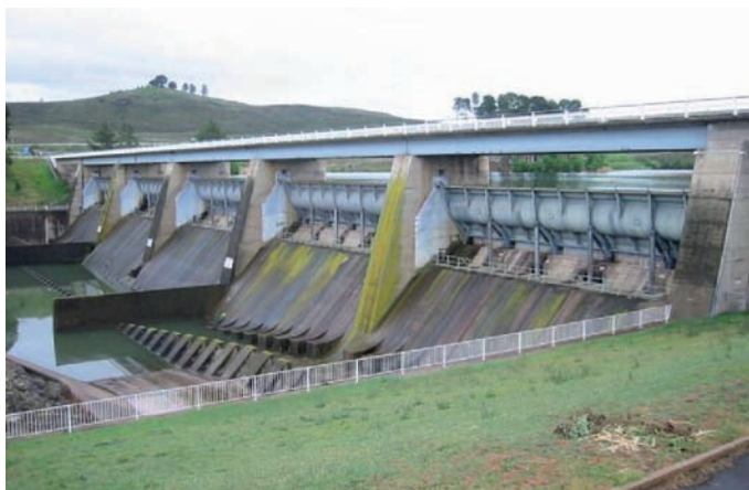
Fig. 7 Évacuateur avec vannes, Barrage Scrivener, Canberra, Australie
