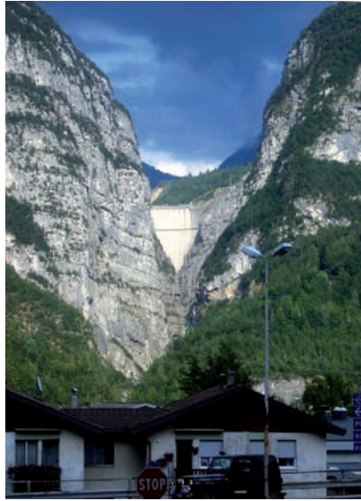
Fig. 2. Barrage-voûte du Vajont en Italie
