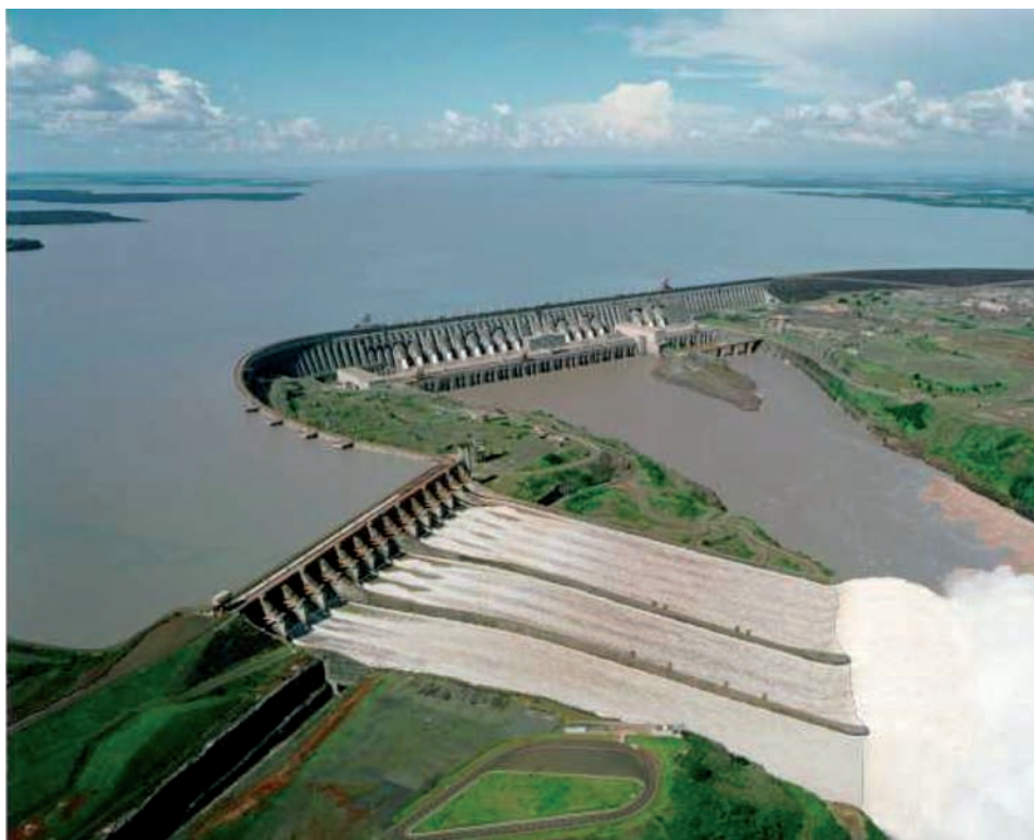
Fig. 6 Déversoir avec vannes, Itaipu, Brésil
