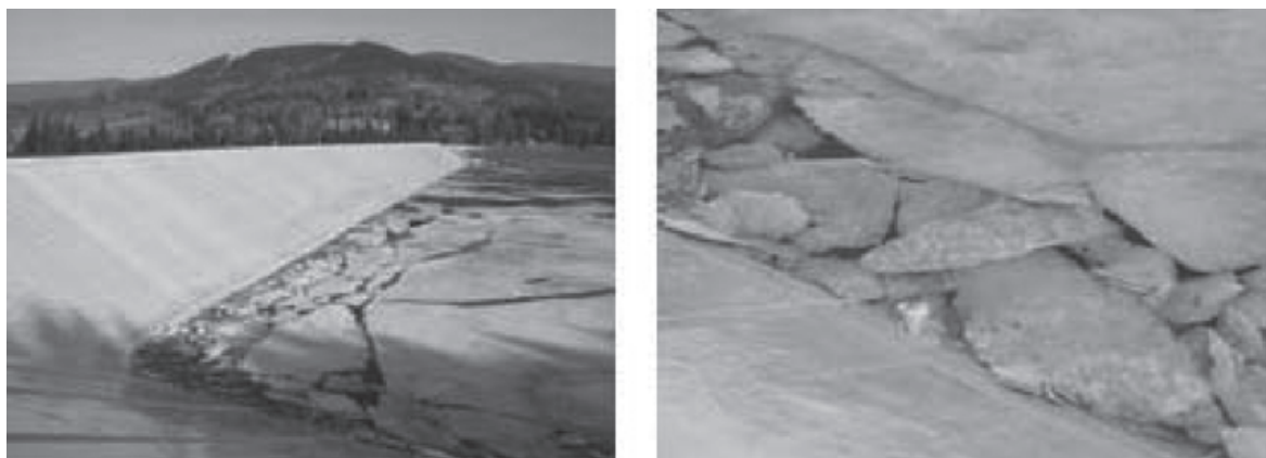
Fig. 41et 42 Moravka, République Tchèque : la glace n'a pas endommagé la géomembrane exposée installée en 1999
