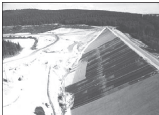
Vue générale du barrage pendant la construction du dispositif d'étanchéité
